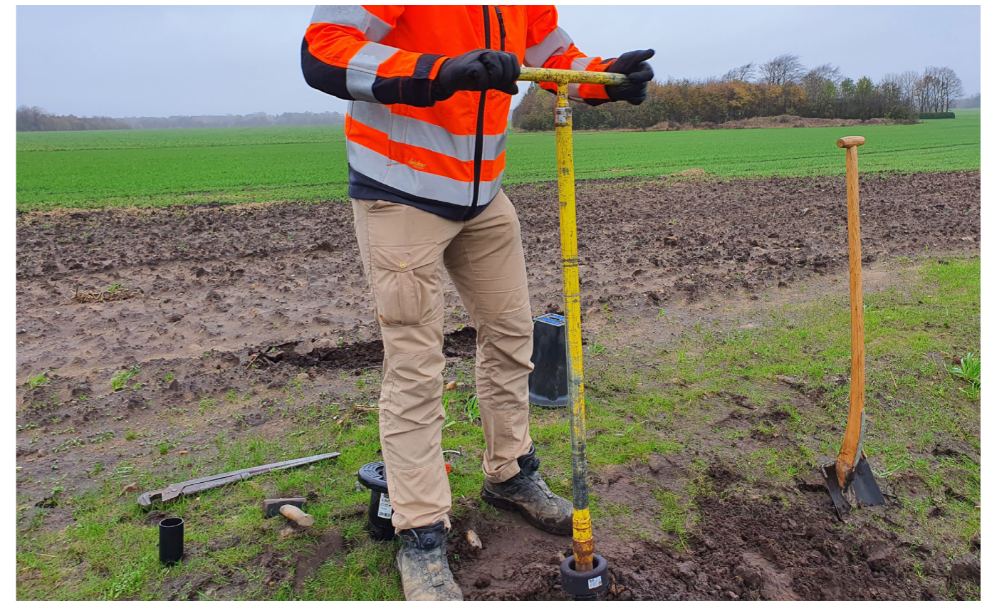
Der VIDI-Positioner ist kalibriert und bereit, die Stellung des Schiebertentils zu erfassen.
