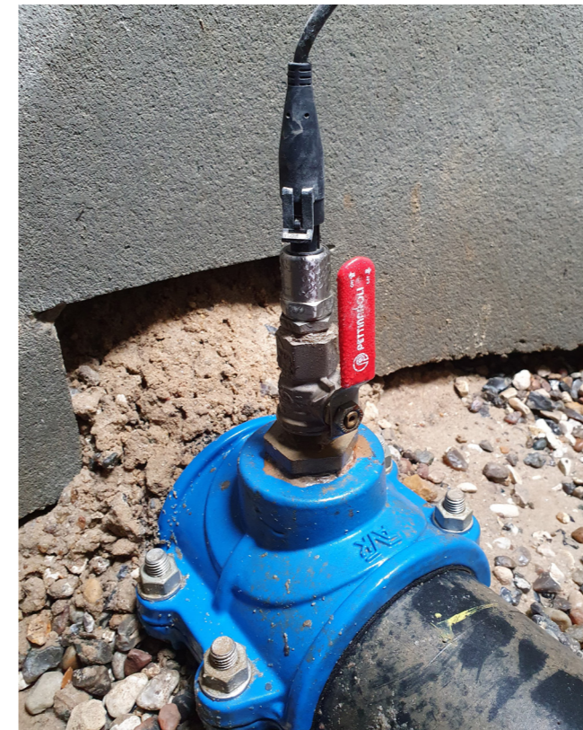
Aufgrund der drahtlosen Natur des IoT können die Drucksensoren an jedem kritischen Punkt des Verteilungsnetzes installiert werden.
