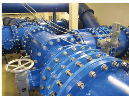
Die Rohrkupplungen von AVK sind geeignet für Gussrohre, Stahlrohre sowie PE- und PVC Druckrohre. Das Kombiflanschprogramm von AVK umfasst zugfeste Kombiflansche für PE-, PVC- und Duktulgussrohre sowie nicht zugfeste Kombiflansche für PVC-, Stahl- und Duktulgussrohre.
