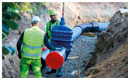
Die Schieber-Rohr-Verbindung ist patentiert und vom DVGW zugelassen. Ein Standard-PE-Rohr wird direkt auf das mit einer Nut versehene Schieberende aufgepresst. Die patentierte Gestaltung der Nut sowie eine Hülse um die Schieber-Rohr-Verbindung herum sorgen dafür, dass das PE-Material in die Nut hinein gepresst wird. Der durch die Hülse erzeugte Druck stellt sicher, dass die schraubenlose Verbindung dicht und
